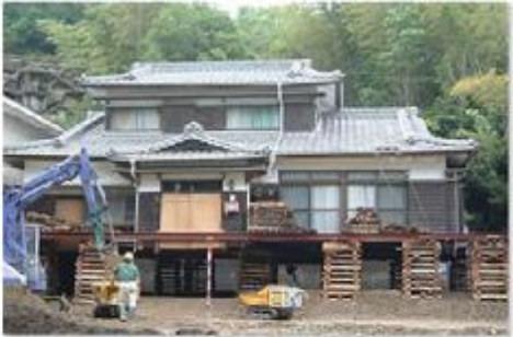
宅地嵩上げ・ピロティ
