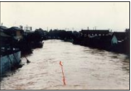
西除川(新布忍橋より下流)S57.8
