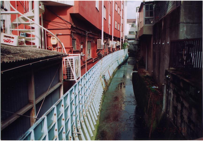
③ 右岸…鋼製護岸(上流を見る)
