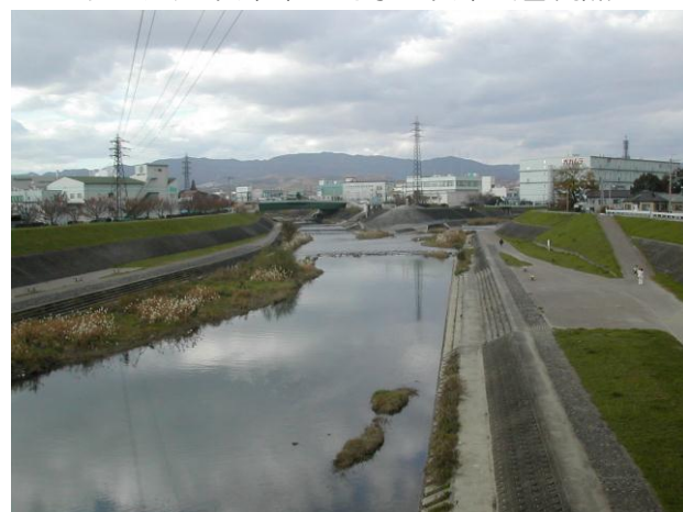
安威川 茨木市西河原 茨木川合流点
