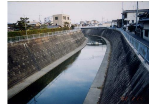
① 山田川 摂津市正雀 一の橋下流
