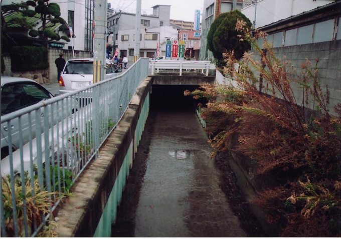
④ 上流は暗渠(上流を見る)
