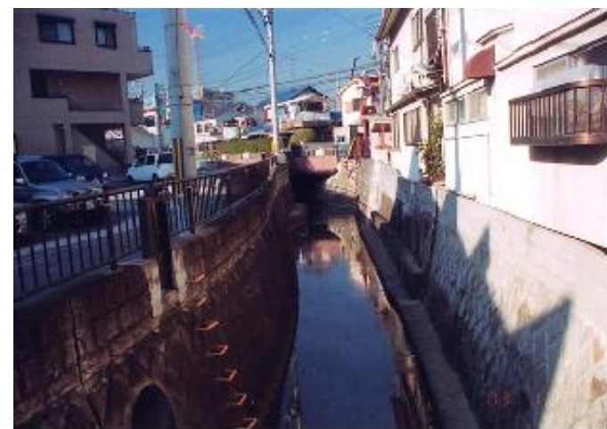
⑦ 管理区間上流(春日丘橋を望む)
