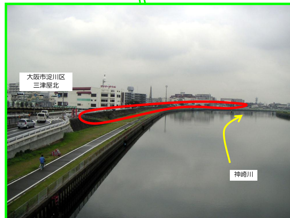
神洲橋より下流を撮影
