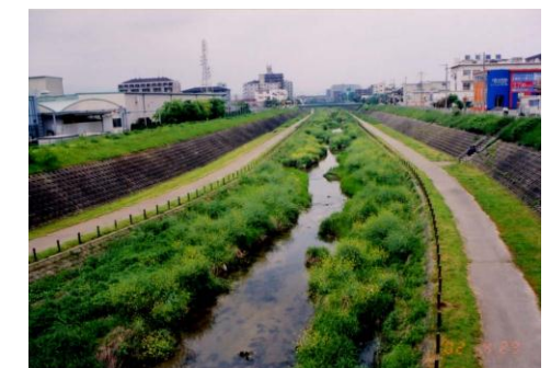
④ 大正川 茨木市沢良宜 大正川橋上流
