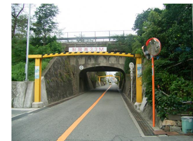
高川 吹田市江坂町 水路橋
