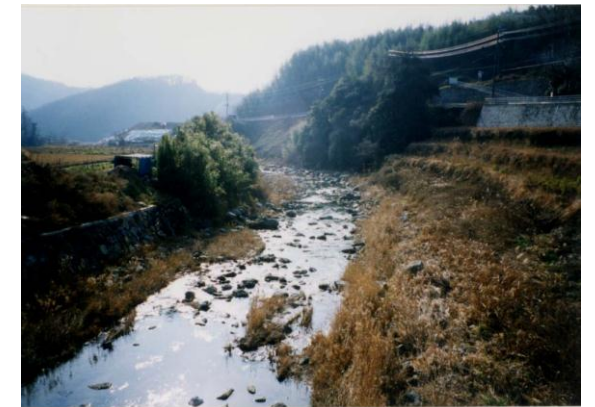
③ 安威川 茨木市車作 登龍橋下流
