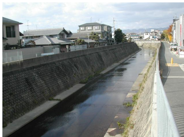
山田川 摂津市東正雀 中道橋下流
