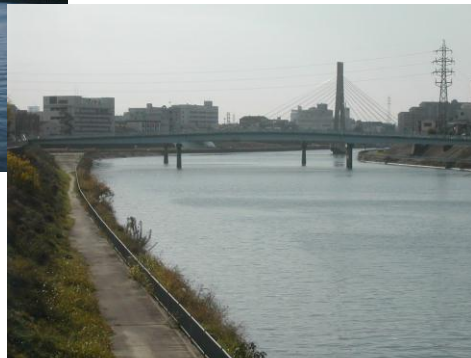
安威川 東淀川区相川 新京阪橋下流
