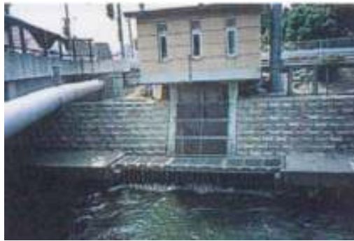
写真 1.8 古川浄化導水路流入部
