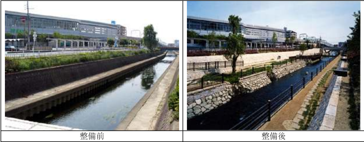
図 2.22 「せせらぎ公園」整備前・整備後 寝屋川親水空間「幸町公園」(寝屋川市幸町)
