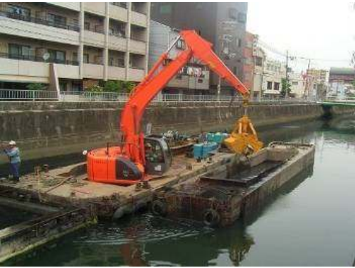
写真 1.6 底質汚泥の浄化浚渫(平野川)
