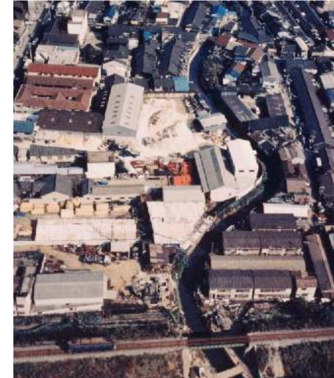
平野川 改修前 城東貨物・竹淵橋付近（昭和44年）
