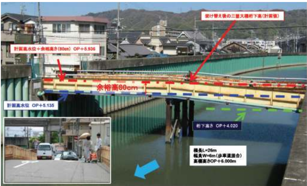
図-73 三箇大橋の現状
