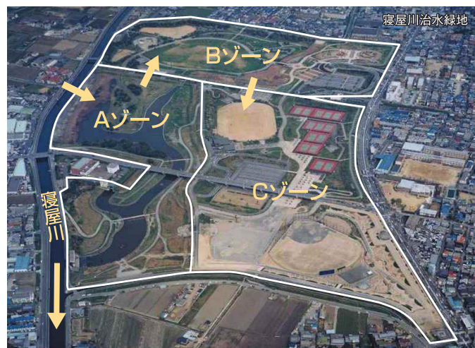
平成11年8月 寝屋川治水緑地 貯留状況
