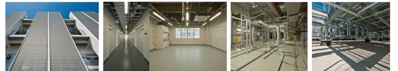
外部に設備配管シャフトを設け、配管配線をクリップ止めとすることにより、構造部材を痛めることなく、設備の改修を容易に
