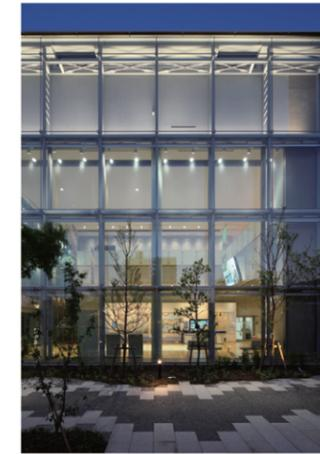
ダブルスキン内の温度及び外気温度を比較し、夏季は高温になったダブルスキン内の空気を屋外へ排出、冬季は暖められた空気を室内に導入する。
