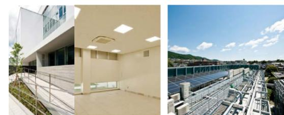
デザインされた外気搬入口 (左) より取り入れた空気を、地中熱によって冷却し共用スペース (右壁上部吹出口) に供給 / 雨水回収槽 (右写真下部) の設置により、雨水を植栽の自動灌水やボイラーフロー水の冷却に活用
