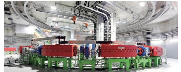
エアコンを装置周囲に分散配置した加速器室
