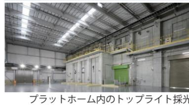
トップライトや太陽光集光照明を設置し、昼光利用している。照明器具はLED、メタルハライドを採用し、消費エネルギーの削減を図っている。
