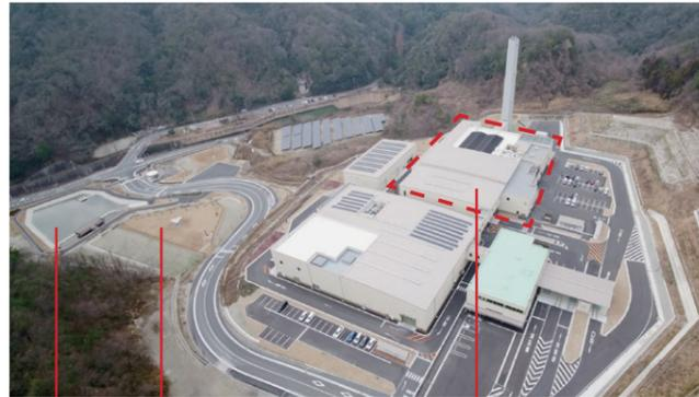
ごみ資源を燃やす中枢である炉、ボイラーが設置される機械室は大容量の熱量である。ドライエリアから取り入れられた空気はドラフト効果により屋根面に設置された防水型ルーバーから全体に排出され動力を使わない自然換気を実現させている。
