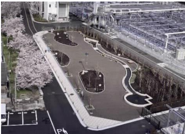
中浜東下水処理場の再構築事例
