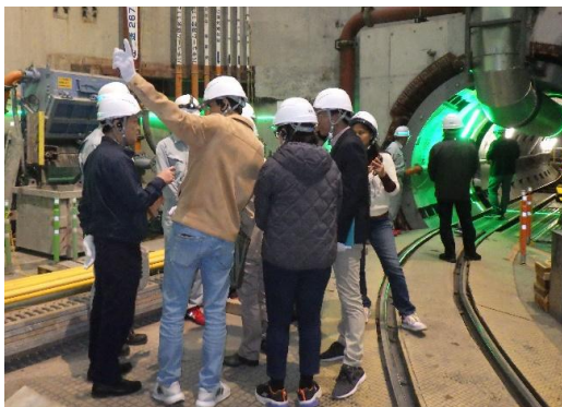
JICA研修員による工事現場視察
