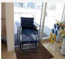
段差のない出入口
