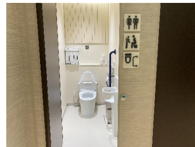
・一般便房に手すりを設置した例 (大阪ヘルスケアパピリオンみんなトイレ)
