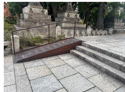
・敷地内通路の段差部に設置された簡易スロープ(住吉大社) 【出典】奈良市バリアフリー事例集
