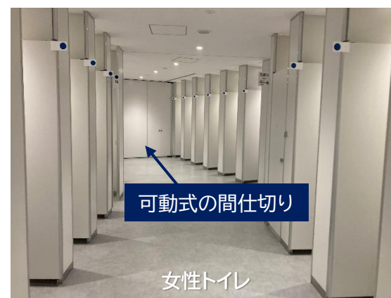
可動式の間仕切り例(シャインハット1Fトイレ)
