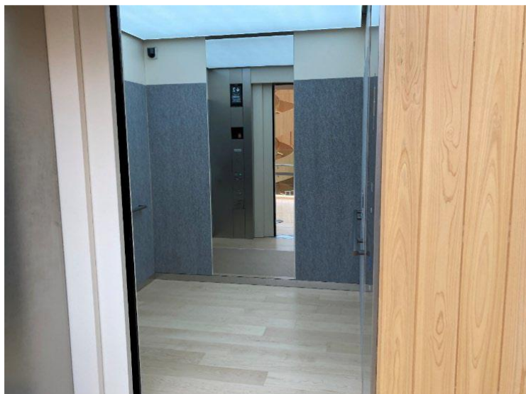
片袖エレベーターの例 (大阪ヘルスケアパビリオン内エレベーター)
