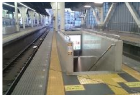
写真：駅ホーム通路幅が狭い事例（南海難波）
