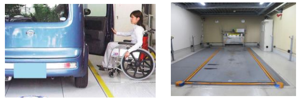
機械式駐車場のパレットのフラット化
