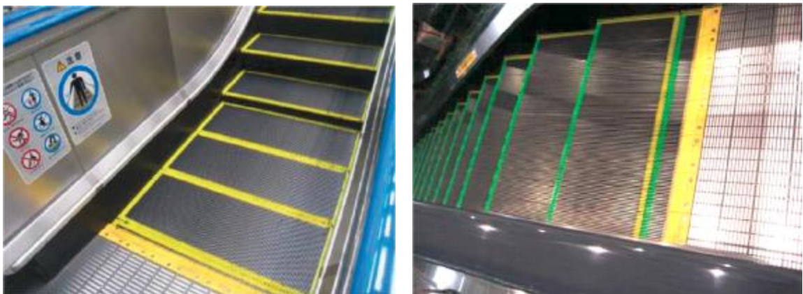
〇図 7.4 四方を縁取りすることで、踏み段の範囲を視認しやすくしている例
