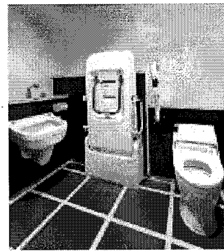
・壁掛け式大型ベッドのある 便所
