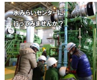
処理場施設見学
