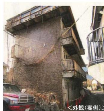
外壁、手すりが崩落した事例
