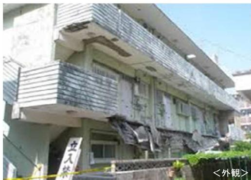
マンションの2階廊下部分が崩落した事例
