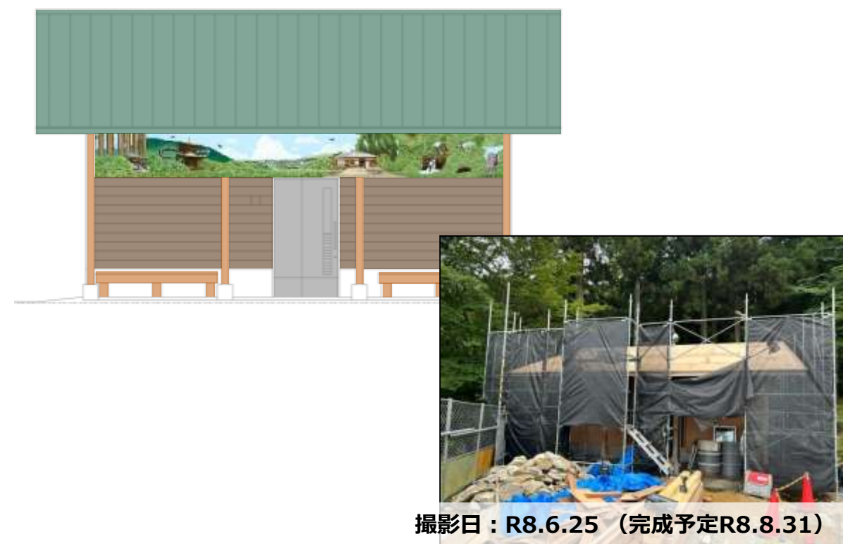
【施工状況（イメージ）】
