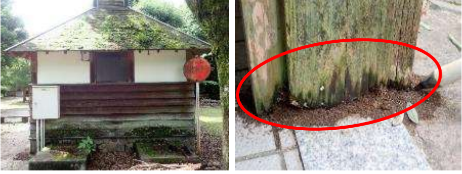
トイレの柱下部が老朽化により腐朽しており、構造上に損傷がある状況
