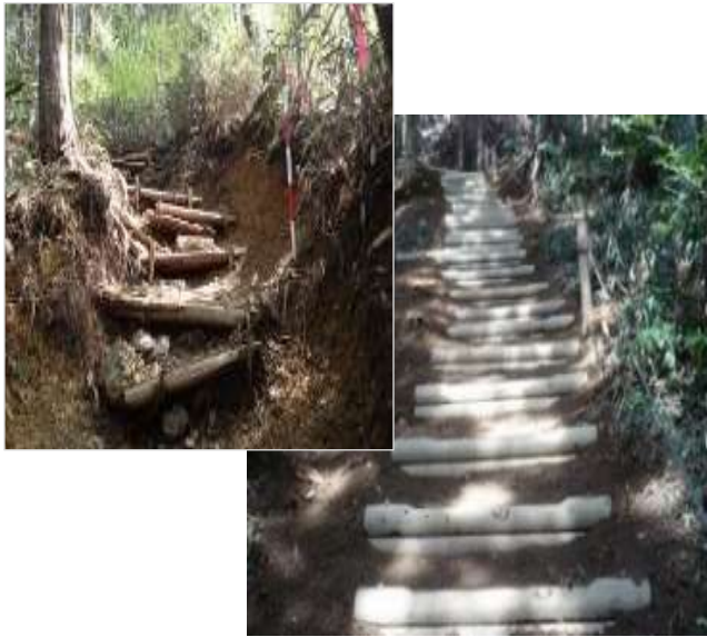
歩道の安全対策
