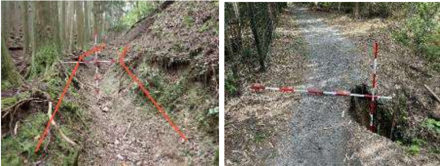
歩道の路肩が崩壊して通行が危険な状況
