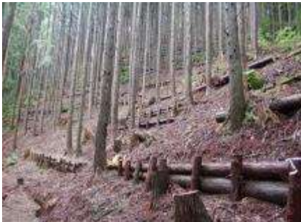
本数調整伐と筋工の施工
