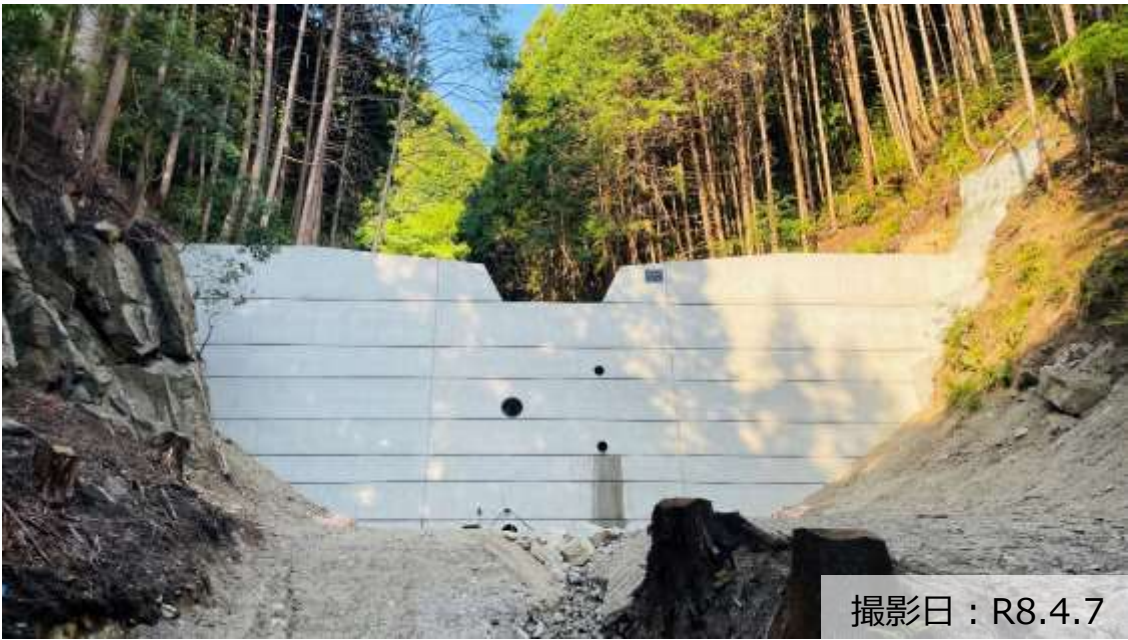
写真① 治山ダムの設置状況
