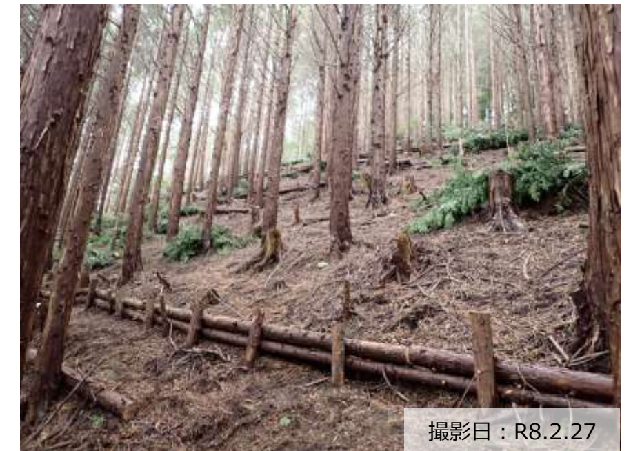
写真② 森林整備（筋工）の実施状況
