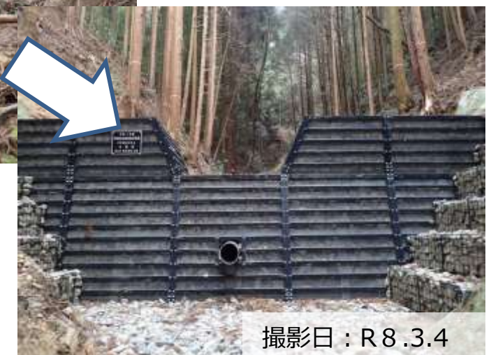
写真② 治山ダムの設置状況
