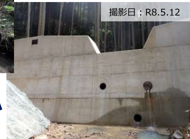
写真② 治山ダム（コンクリート）の設置状況
