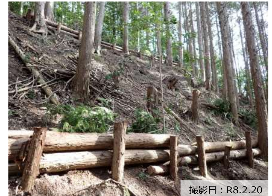
写真① 森林整備（本数調整伐・筋工）の実施状況
