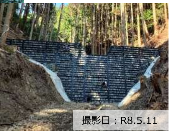
写真② 施工後 治山ダム（鋼製）の設置状況
