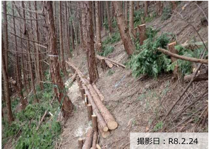
写真② 森林整備（筋工）の実施状況
