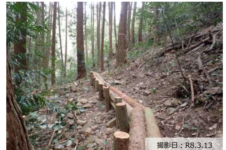
写真② 森林整備（筋工）の実施状況
