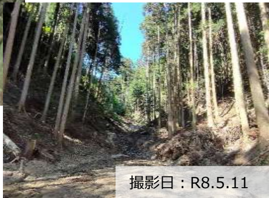
写真③ 流木対策工の実施状況 施工後
