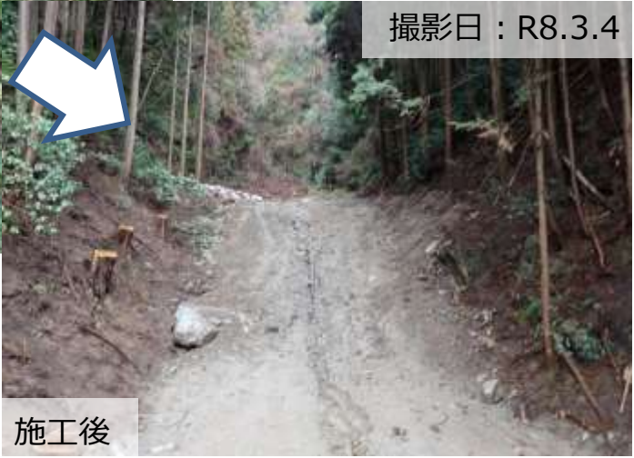
写真② 流木対策工の実施状況
