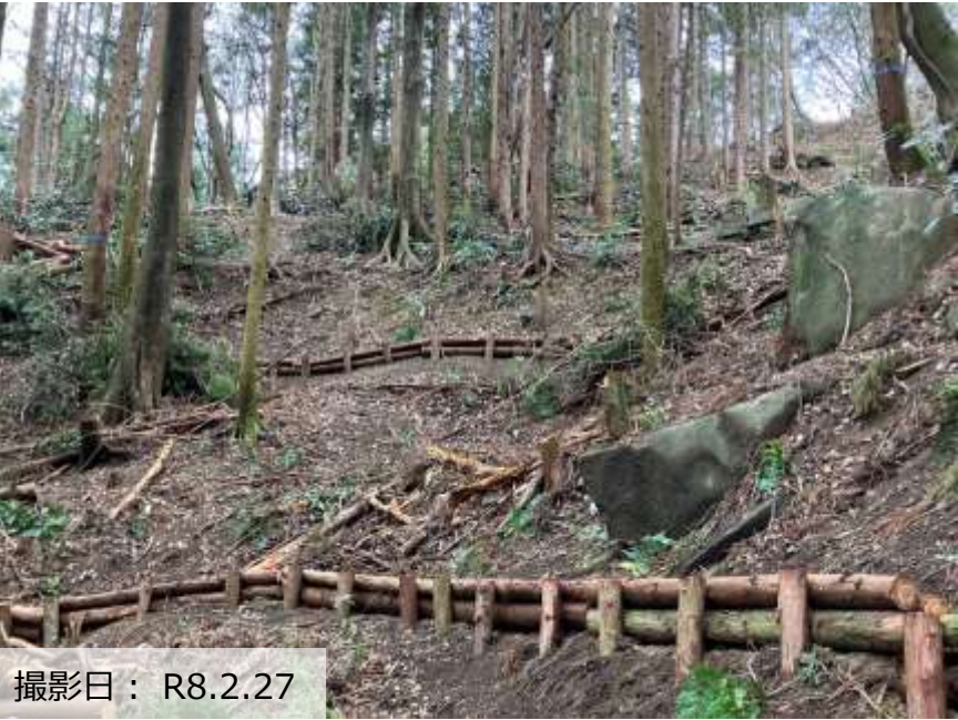
写真② 森林整備（筋工）の実施状況
