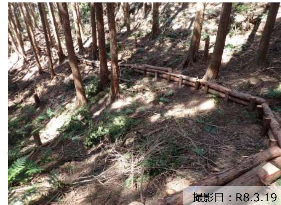
写真② 森林整備（筋工）の実施状況
