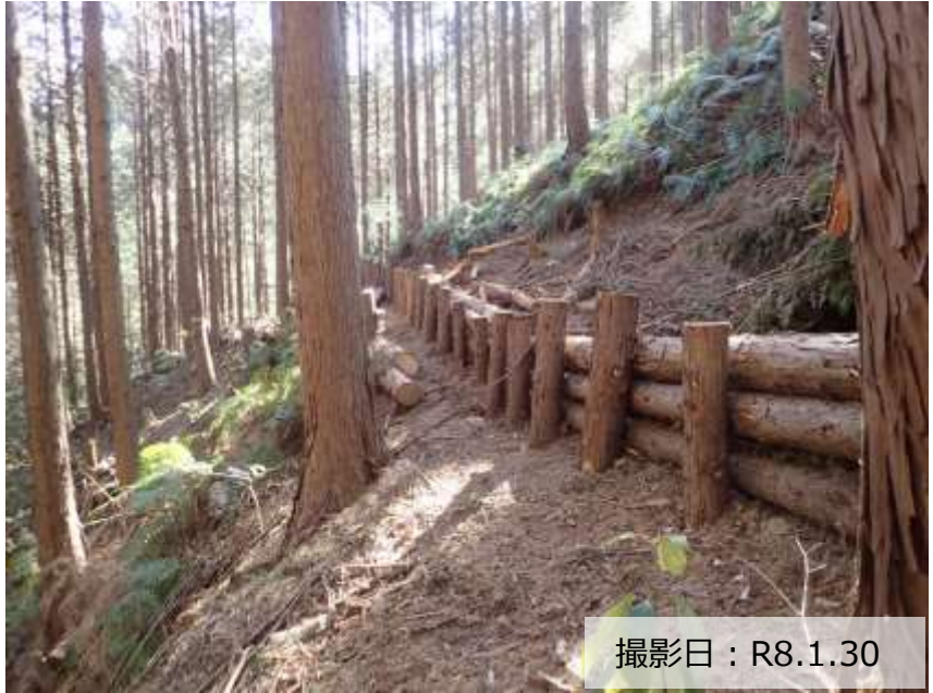
写真② 森林整備（筋工）の実施状況
