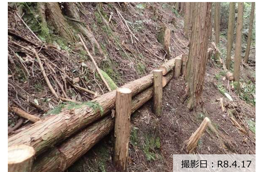
写真② 森林整備（筋工）の実施状況
