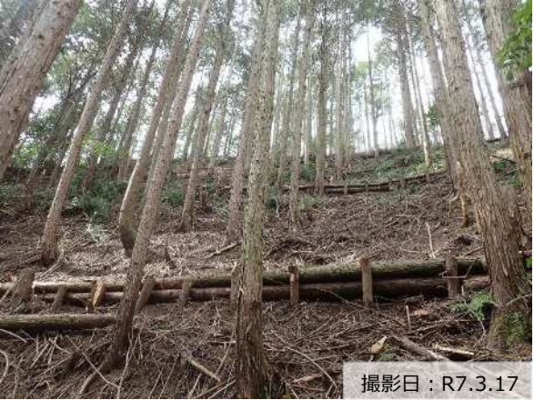
写真② 森林整備（筋工）の実施状況
