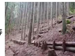
本数調整伐と筋工の施工
