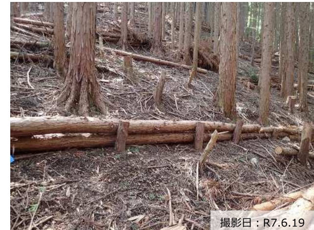
写真② 森林整備（筋工）の実施状況
