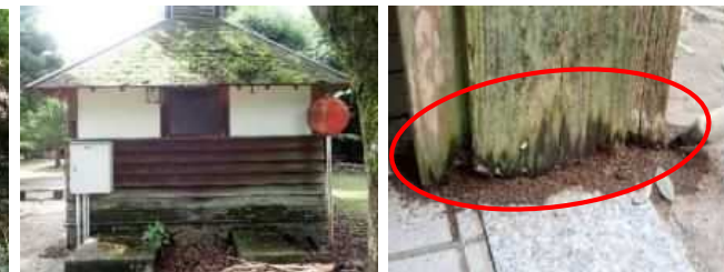
トイレの柱下部が老朽化により腐朽しており、構造上に損傷がある状況
