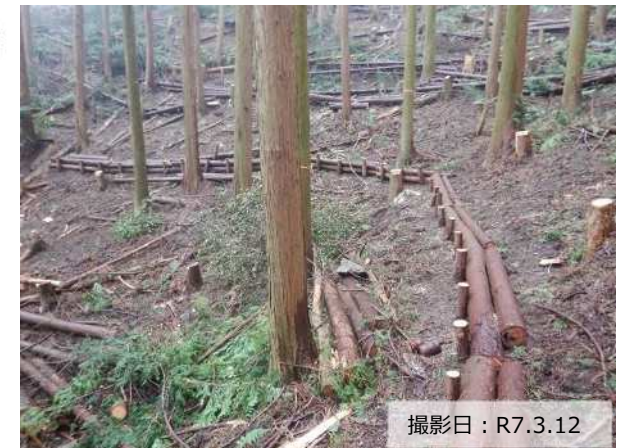
写真② 森林整備（筋工）の実施状況
