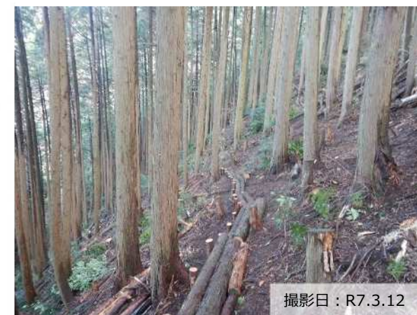
写真② 森林整備（筋工）の実施状況
