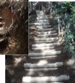
歩道の安全対策
