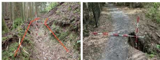
歩道の路肩が崩壊して通行が危険な状況
