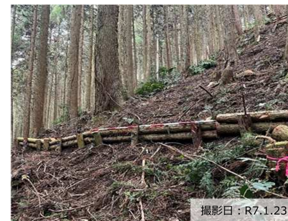
写真② 森林整備（筋工）の実施状況
