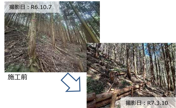
写真② 森林整備（筋工）の実施状況 施工後
