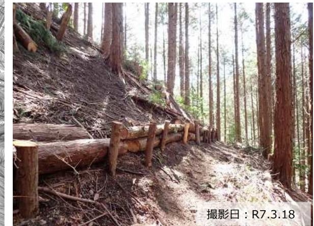
写真② 森林整備（筋工）の実施状況
