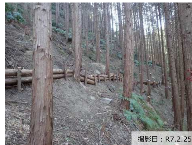
写真② 森林整備（筋工）の実施状況
