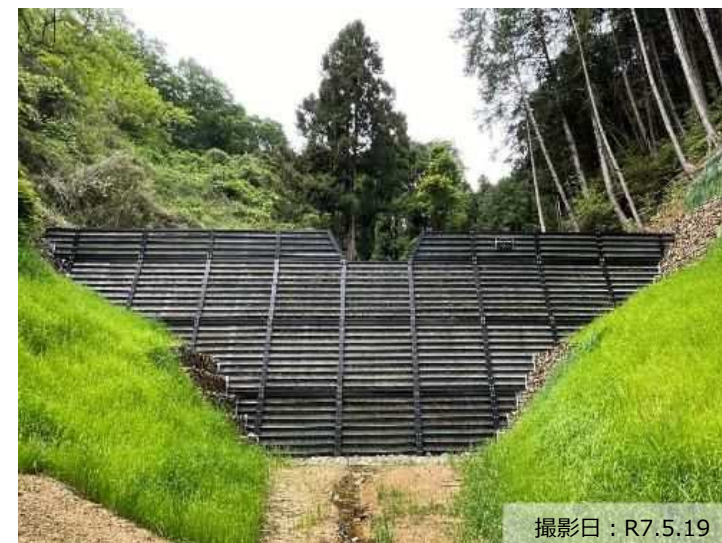
写真① 治山ダム（鋼製）の設置状況
