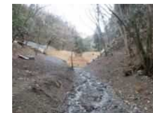
渓流沿いの危険木の除去
