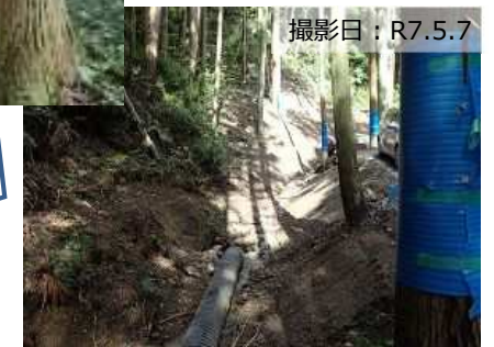
写真② 流木対策の完了状況
