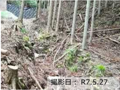
写真② 流木対策の完了状況
