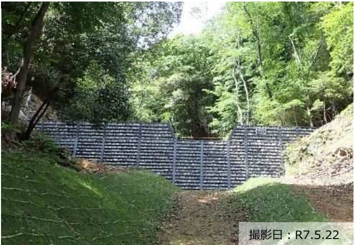
写真① 治山ダム（鋼製）の設置状況
