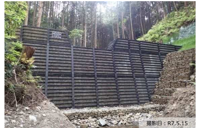
写真① 治山ダム（鋼製）の設置状況
