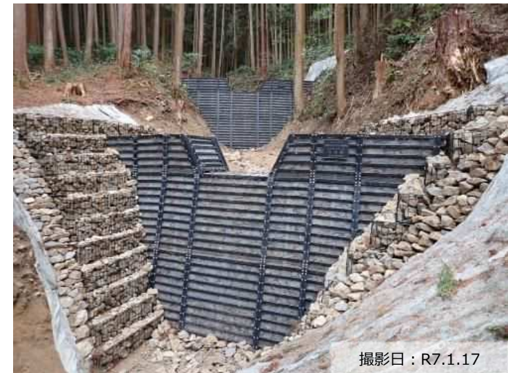
写真① 治山ダム（鋼製）の設置状況
