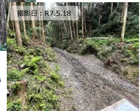
写真① 流木対策の完了状況
