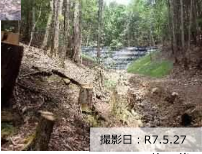
写真② 流木対策の完了状況
