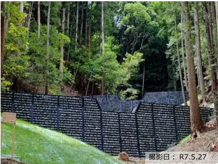
写真① 治山ダム（鋼製）の設置状況
