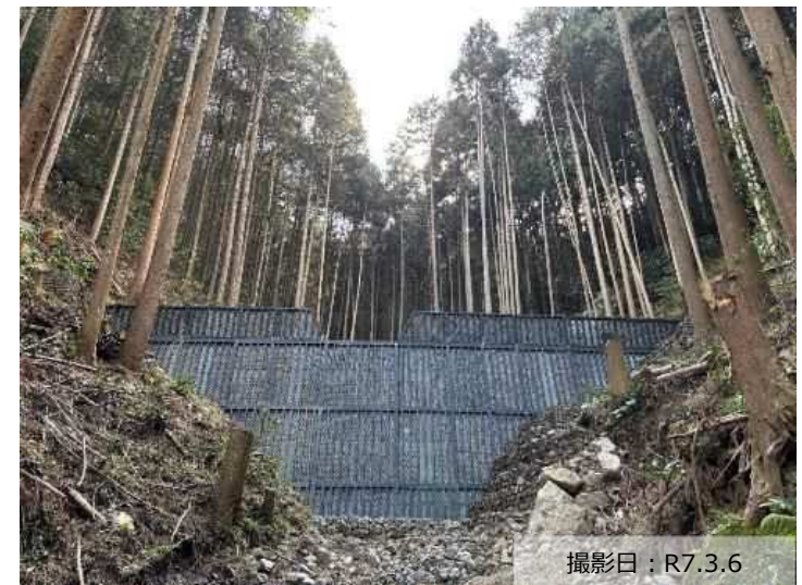
写真① 治山ダム（鋼製）の設置状況
