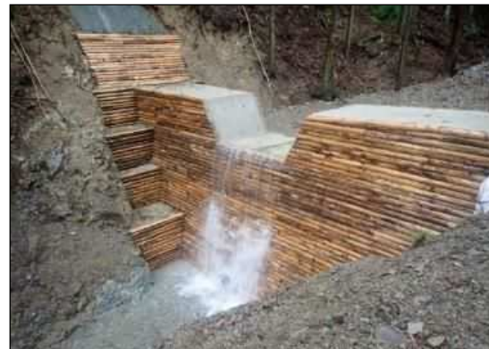
治山ダムの設置により、溪流勾配を緩和し、 土石流の発生を未然に防止(貝塚市)
