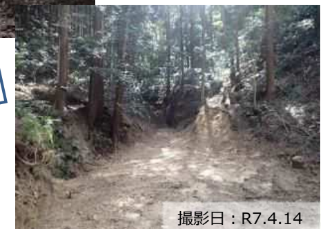
写真② 流木対策工の完了状況
