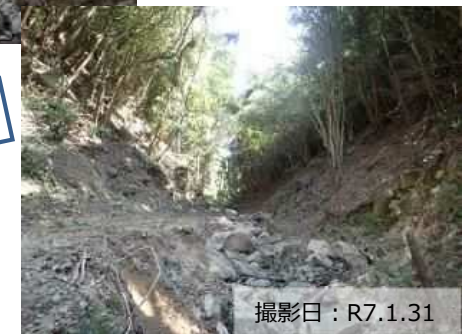
写真② 流木対策工の完了状況
