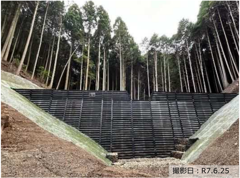
写真① 治山ダム（鋼製）の設置状況
