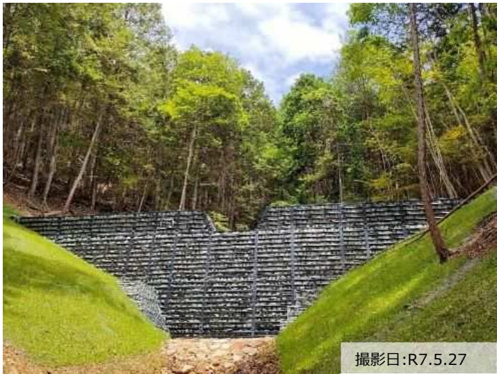
写真① 治山ダム（鋼製）の設置状況
