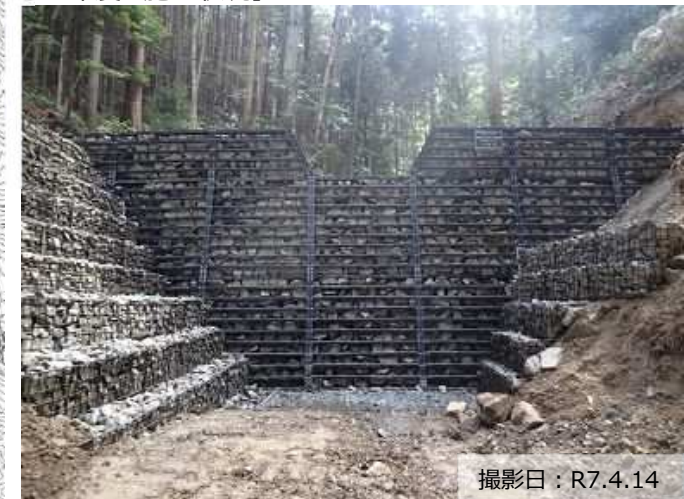
写真① 治山ダム（鋼製）の設置状況
