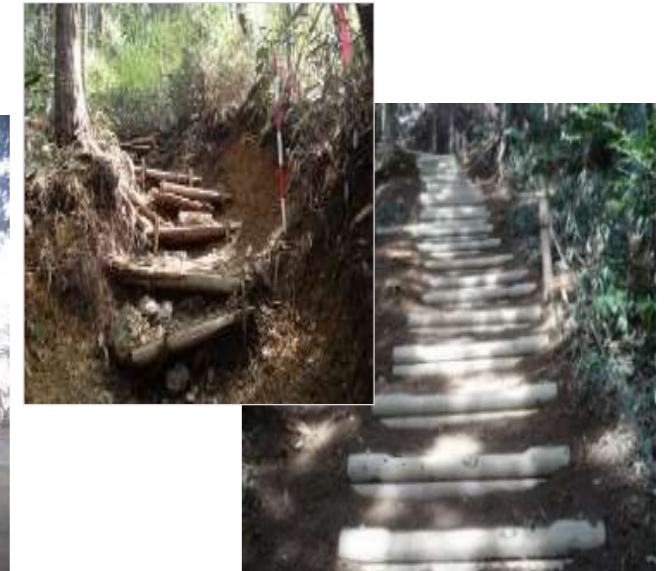
歩道の安全対策
