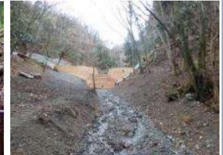
本数調整伐と筋工の施工
