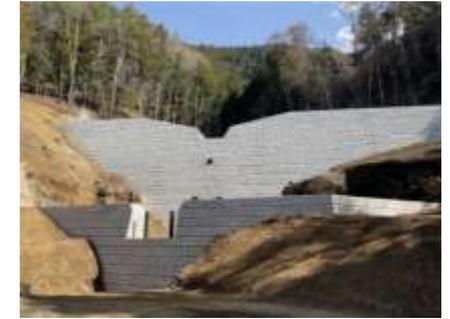
ピーク流量調整機能のある流域治水対策ダムの設置
