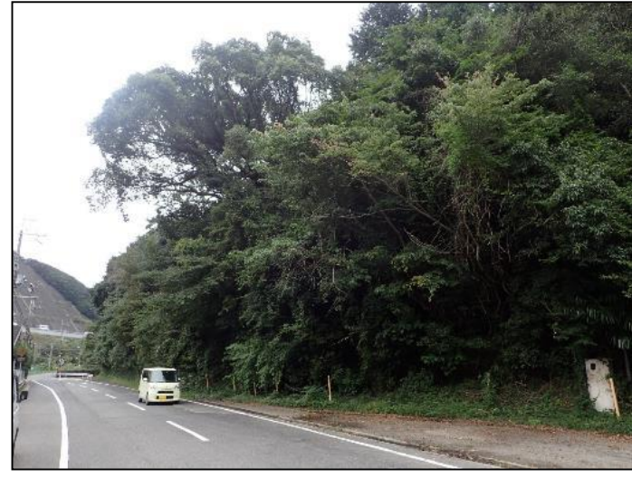
府道64号（阪南市） 施工前
