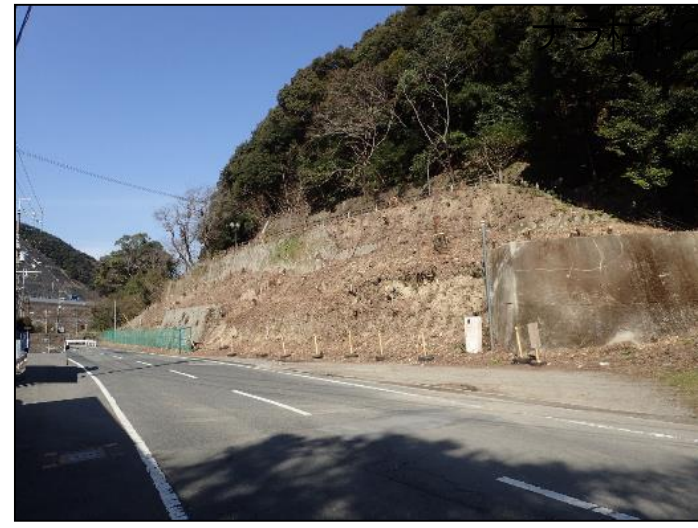
施工後 ナラ枯2.2ha
