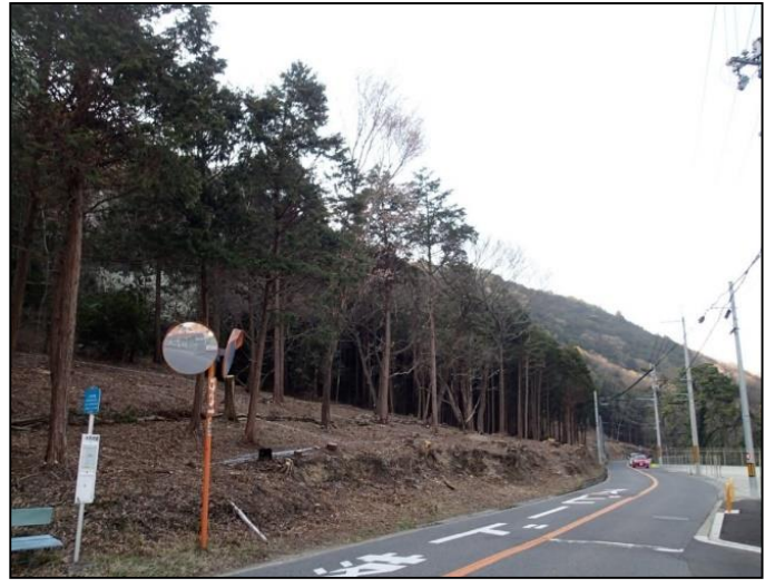
施工後 ナラ枯6.9ha
