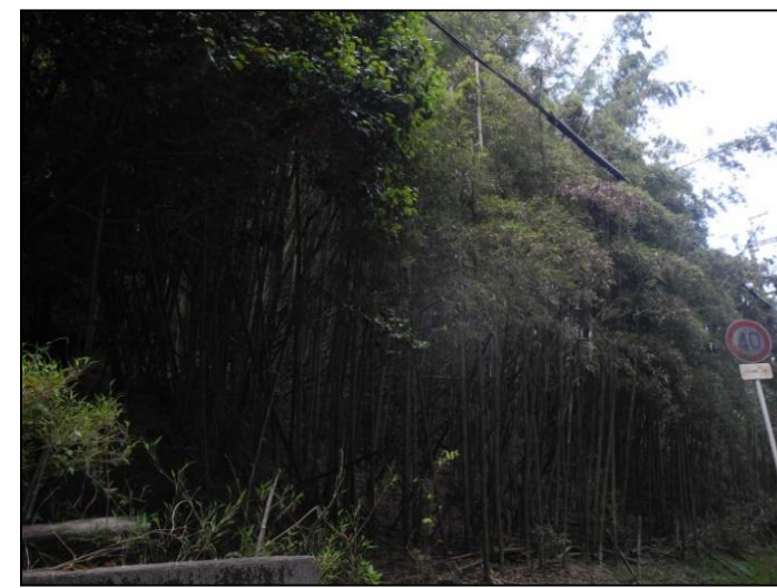
府道79号（高槻市/島本町） 施工前
