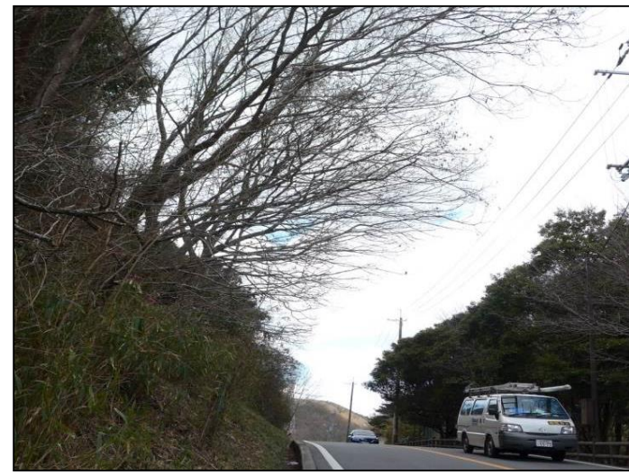
府道8号（四條畷市） 施工前
