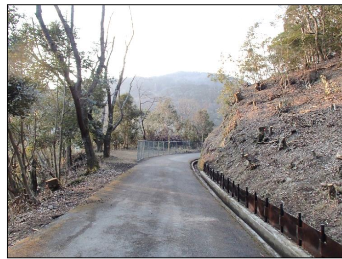
施工後 ナラ枯16.5ha
