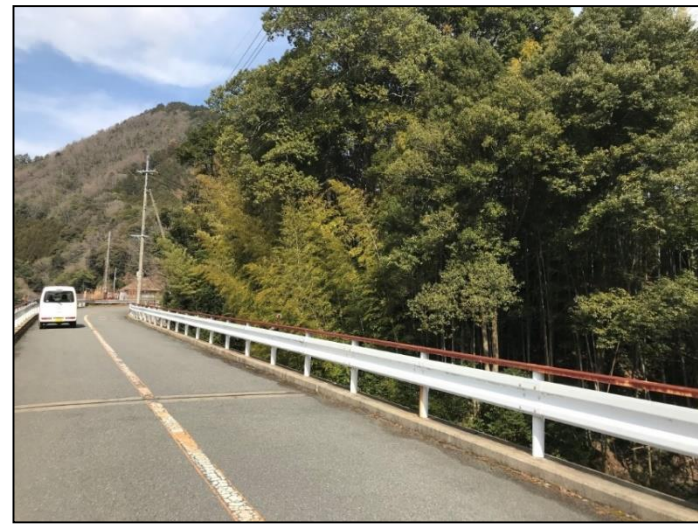
府道61号（河内長野市） 施工前
