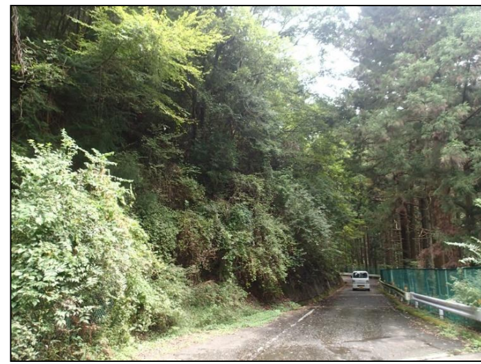
国道480号（和泉市） 施工前
