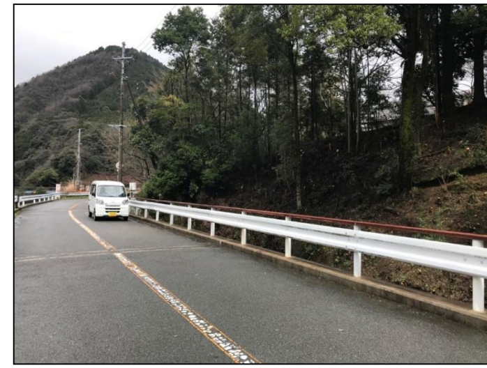
施工後 ナラ枯10.3ha 竹林 0.8ha
