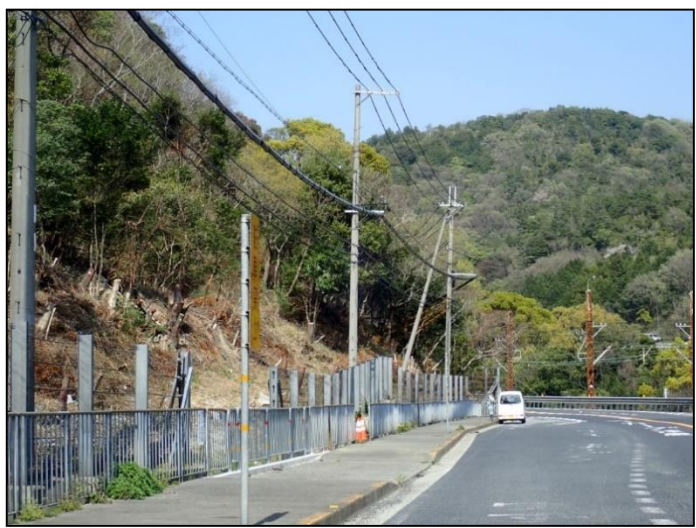
施工後 ナラ枯9.4ha
