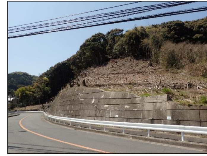
施工後 ナラ枯0.3ha 竹林 0.2ha
