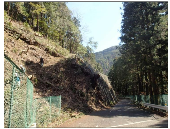
施工後 ナラ枯2.4ha 竹林 0.3ha
