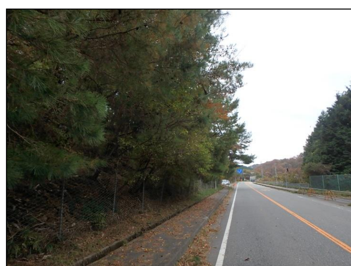
国道173号（能勢町） 施工前
