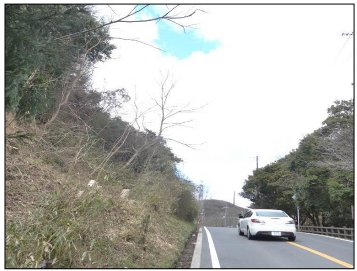
施工後 ナラ枯2.5ha
