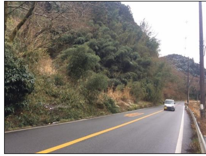
国道309号（千早赤阪村） 施工前
