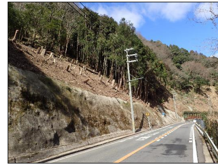
施工後 ナラ枯0.9ha
