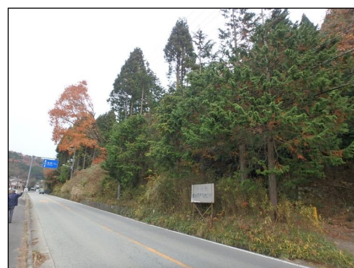
国道423号（豊能町） 施工前
