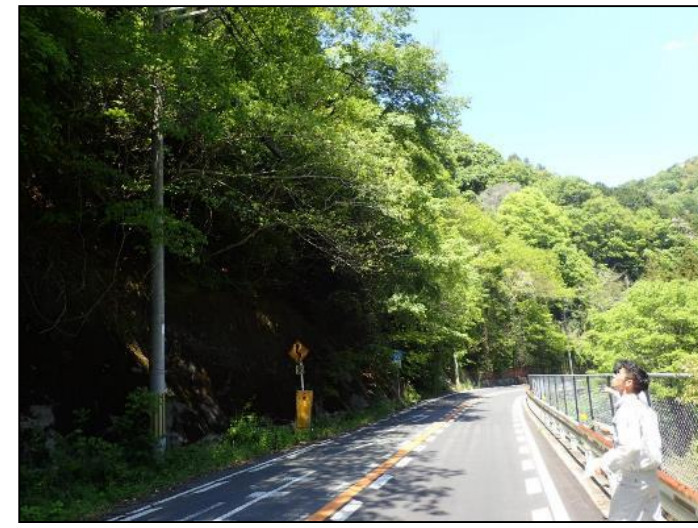
府道39号（岸和田市） 施工前
