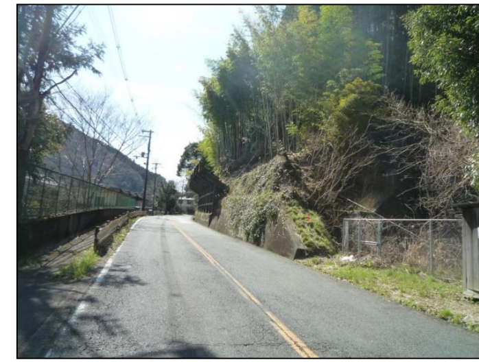
施工後 ナラ枯0.3ha 竹林 1.0ha
