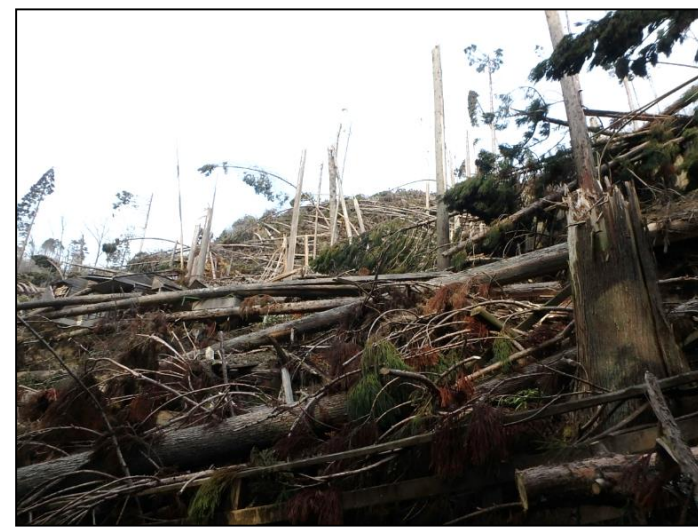
府道6号（高槻市） 施工前
