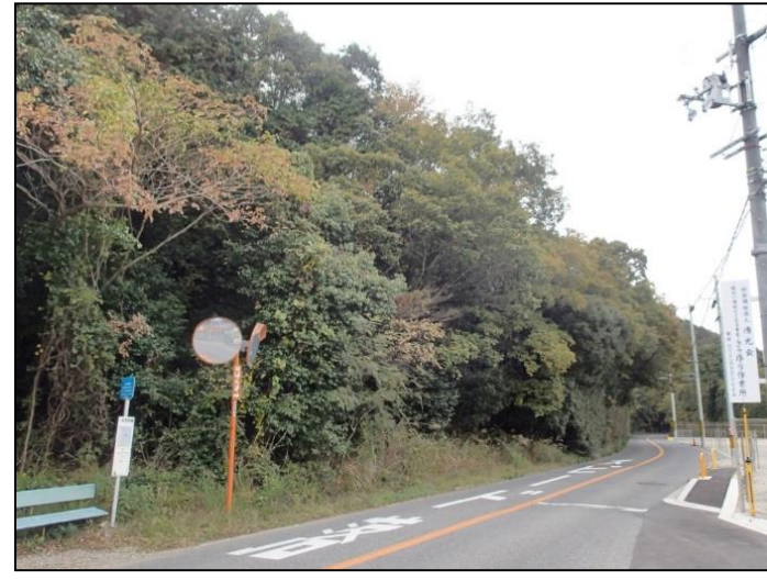
府道62号（泉佐野市/熊取町） 施工前
