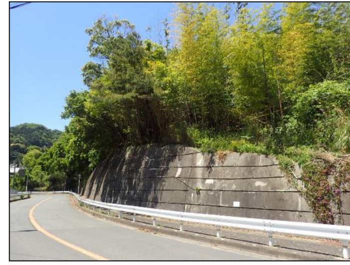
府道63号（泉南市） 施工前
