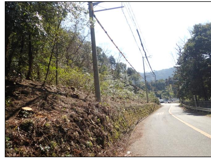
施工後 ナラ枯1.2ha
