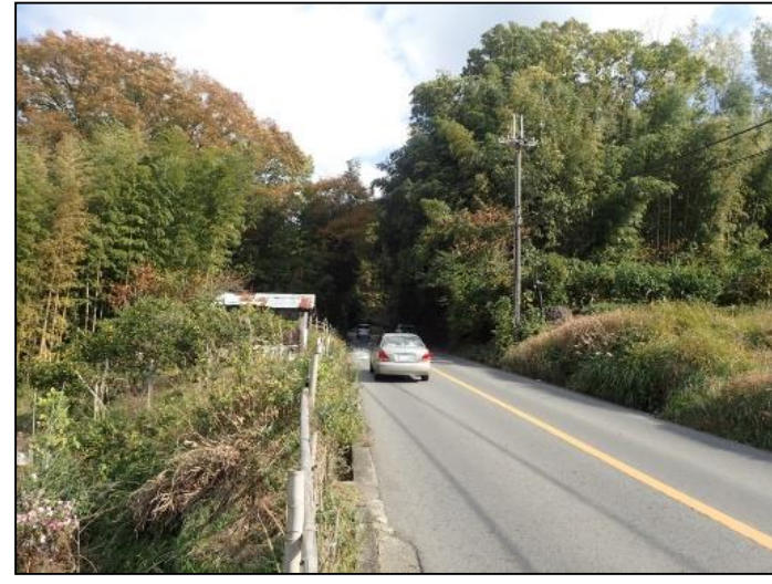
国道166号（太子町） 施工前
