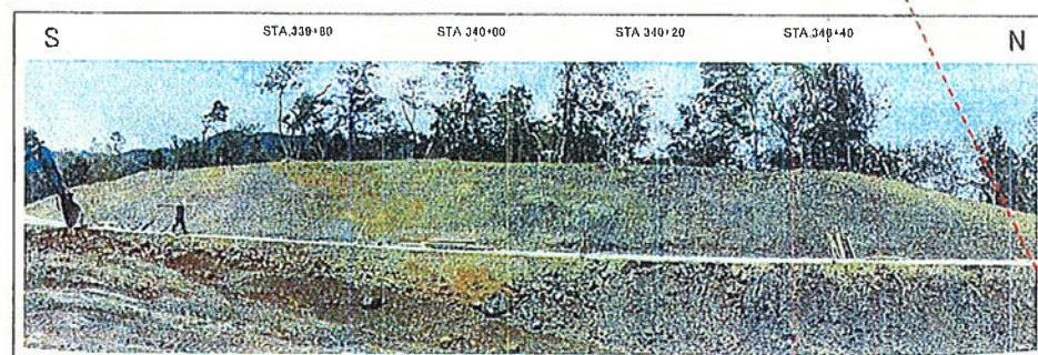
西側法面写真(長さ約90m、高さ約12m)
