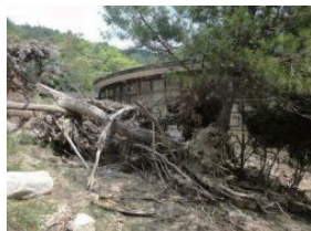
町施設に土石流が押し寄せた
