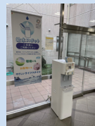
公共施設に給水機を設置 (豊中市※4)
