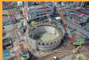
寝屋川北部の地下河川「城北立坑」 施工状況
