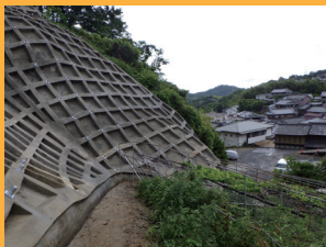
急傾斜地の崩壊対策（法面の保護）
