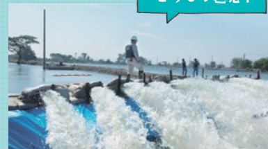
国際緊急援助隊による排水作業
