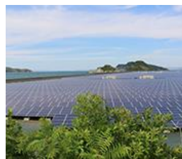
有田太陽光発電所
