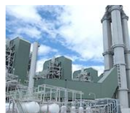
姫路第二発電所（火力）
