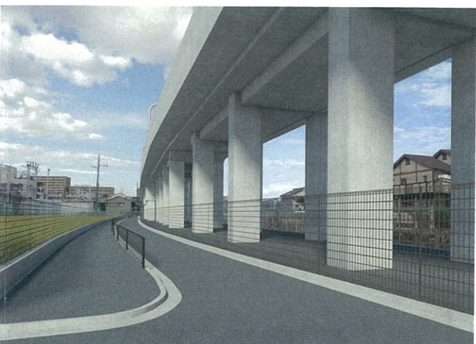
<完成後の景観／南中振公園付近>
