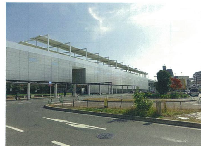
＜完成後の景観／香里園駅付近＞
