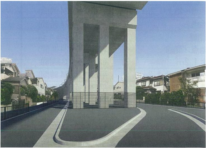
<完成後の景観／旧国道170号付近>
