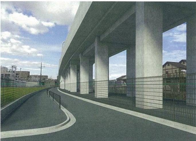
＜完成後の景観／南中振公園付近＞
