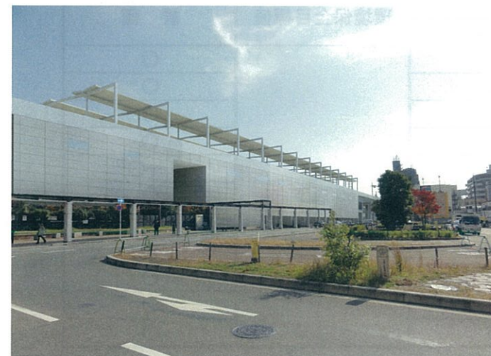
＜完成後の景観／香里園駅付近＞
