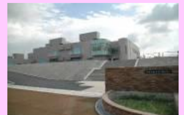
水みらいセンター（下水処理場）
