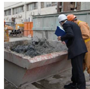
汚染土壌掘削工事の 現地確認状況
