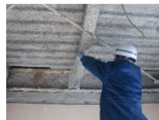
解体現場立入検査
