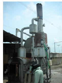
特定施設の現地確認状況
