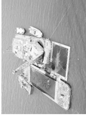
＜神崎川ダイオキシン類浄化対策浸染状況写真＞
