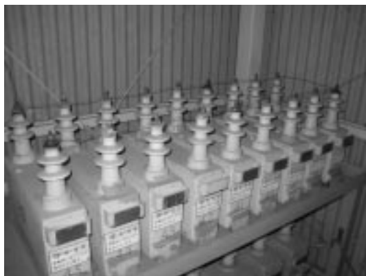
< PCB含有コンデンサの保管 >
