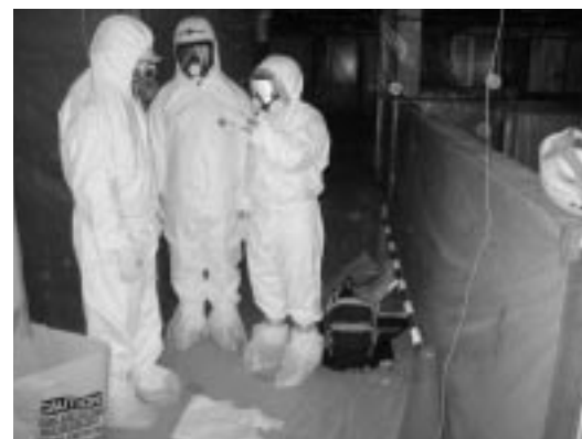
<建築物の解体現場への立入検査の様子>
