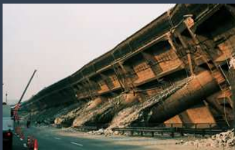
倒壊した阪神高速道路
