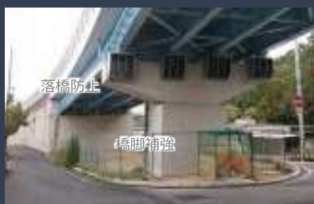
橋梁の耐震補強の様子
