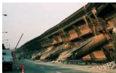
倒壊した阪神高速道路
