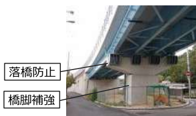
橋梁の耐震補強の様子
