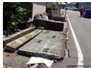
倒壊したブロック塀(新潟県中越沖地震)
