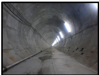
▲鶴見立坑～松生立坑の地下河川内部
