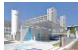
充電設備・水素ステーション整備
