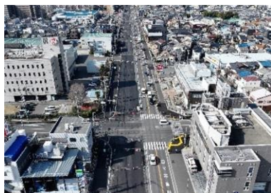
都市計画道路 三国塚口線 令和8年度一部完成予定
