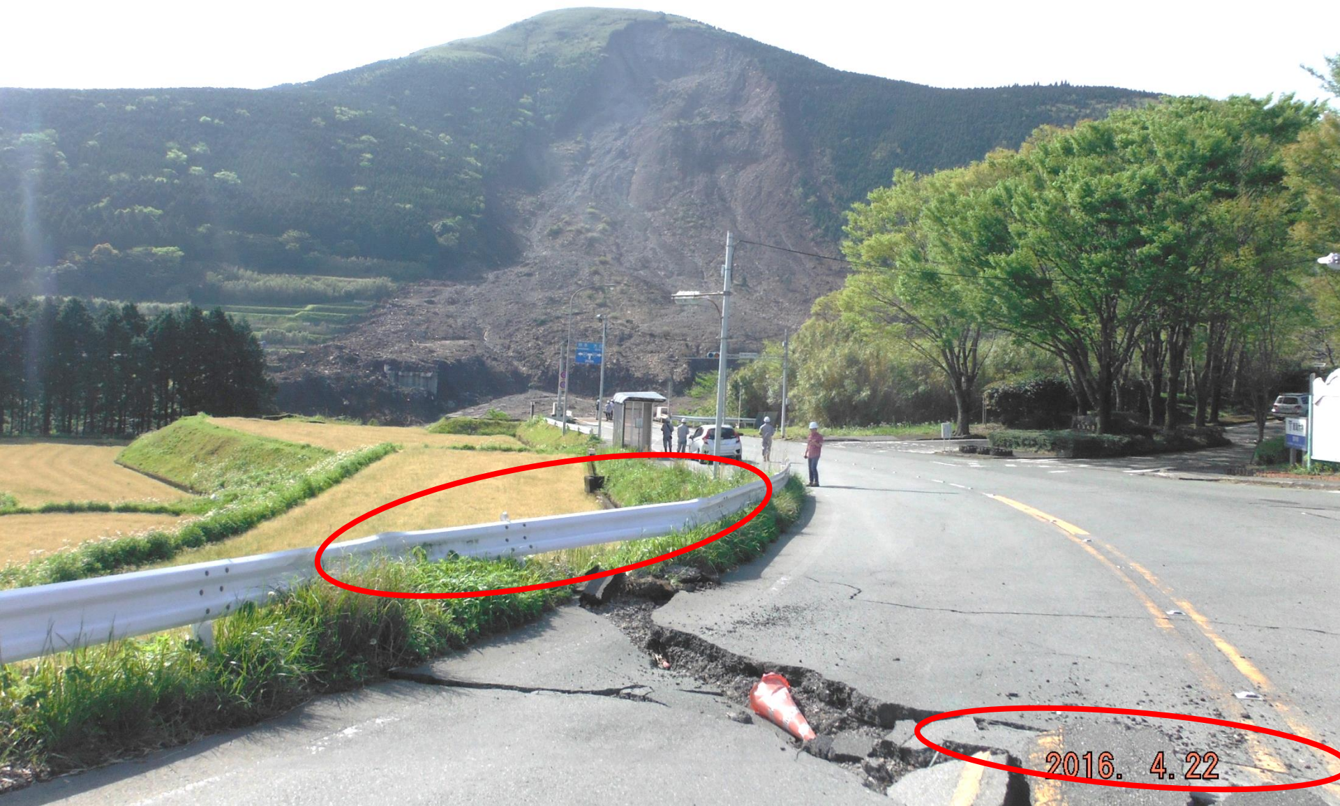
南阿蘇村立野の大崩壊で阿蘇大橋が(黒川に落下、地表地震断層が現れた(県道の中央線が右横ずれ、ガードレールの変形))
