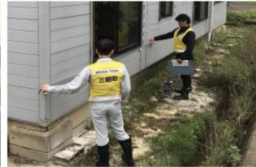
建物被害認定調査 (長野県飯山市)
