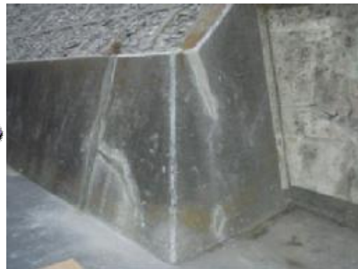
クラック補修（早強モルタル注入）
