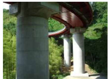
写真 3.1-6 耐震補強(橋脚)
