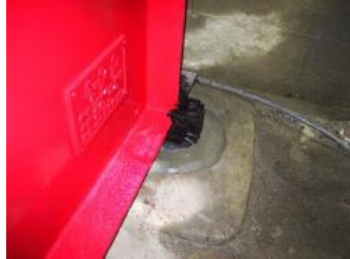
《支承まわりの土砂除去の様子》
