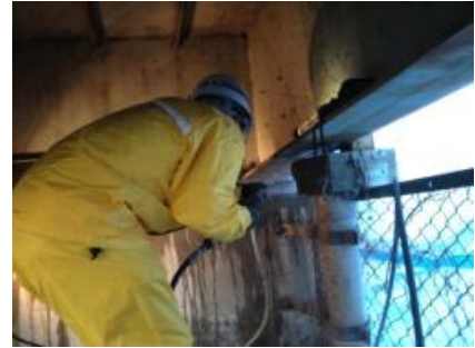
写真 3.1-7 支承のグリスアップ
