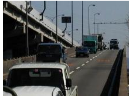
写真 3.1-1 交通量の多い橋梁
