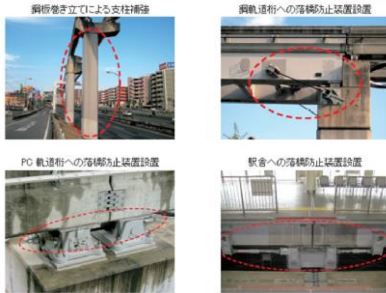
写真 2.2-1 大阪モノレールの耐震補強実施箇所
