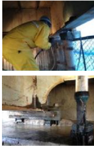
清掃、ケレン作業
