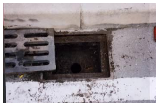
《目詰まり除去後の様子》
