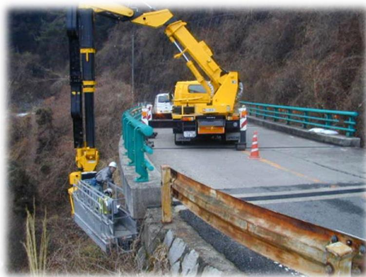
図 4.1-2 作業車での点検風景
