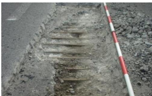
コンクリート床版の輪荷重による疲労損傷
