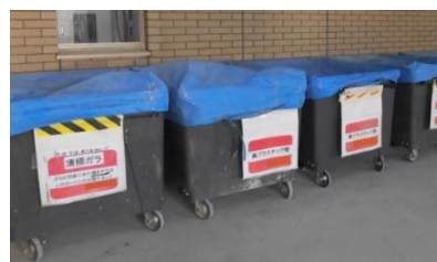
図 4-5 建設廃棄物の現場における分別の例
