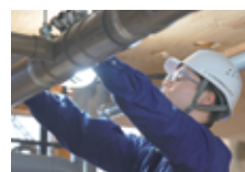
給排水設備施工実習
