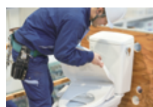
衛生機器取付実習
