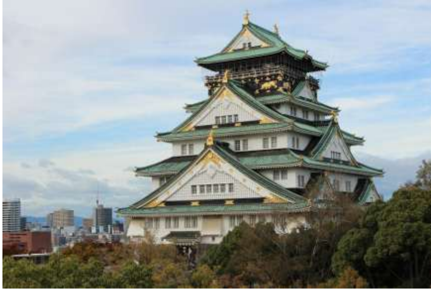
写真 1 大阪城天守閣外観（南東より）
