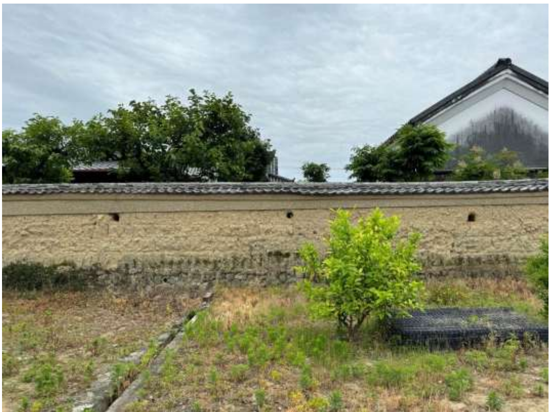
写真4 築地塀（北から）
