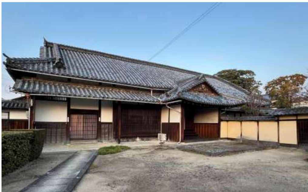
写真1 降井家住宅旧広間全景（南から）
