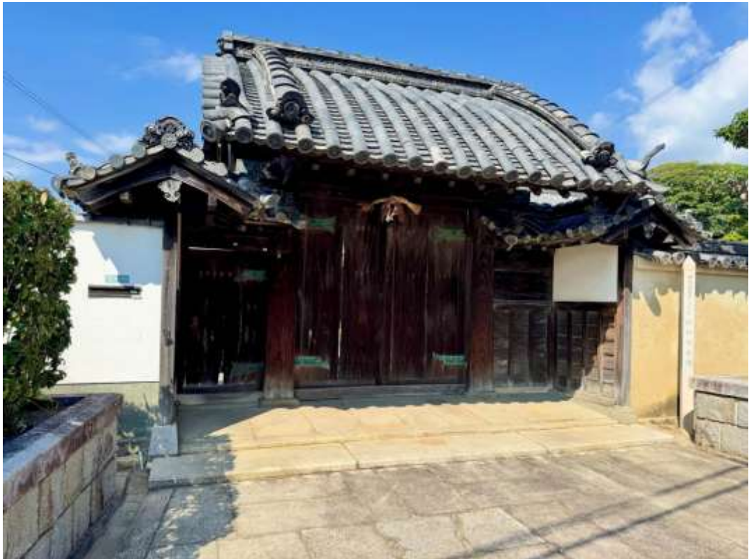
写真3 降井家住宅表門（南西から）
