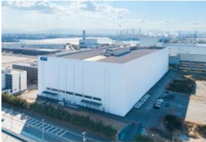
堺市内のデータセンター
