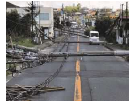
平成30年 台風21号による 電柱倒壊等による道路閉塞 (出典:国土交通省HP)
