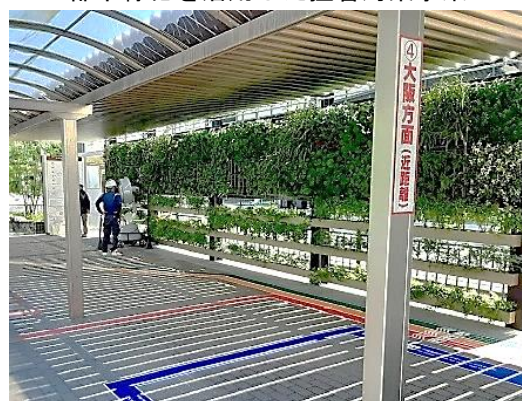
大阪国際空港（大阪府HPより）
