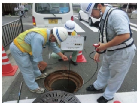
マンホールから下水道管の内部を点検している様子
