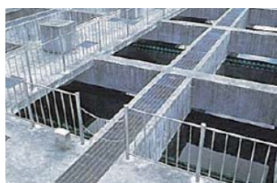
最終沈殿池(さいしゅうちんでんち)
