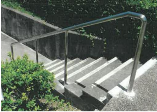
屋外階段への手すり設置の例
