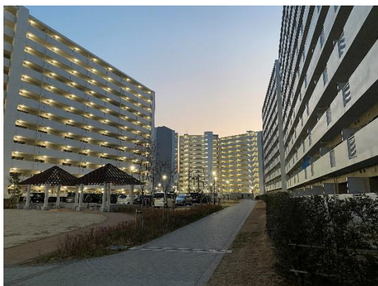
府営堺三原台住宅
