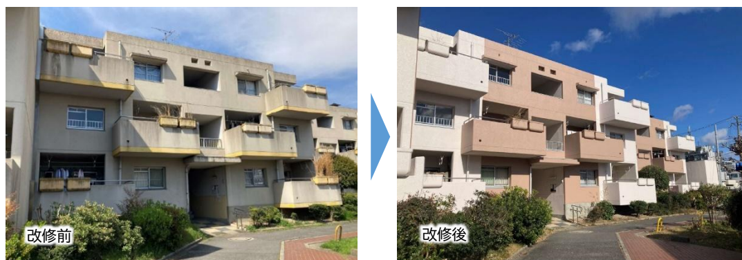
【外壁改修の事例】
