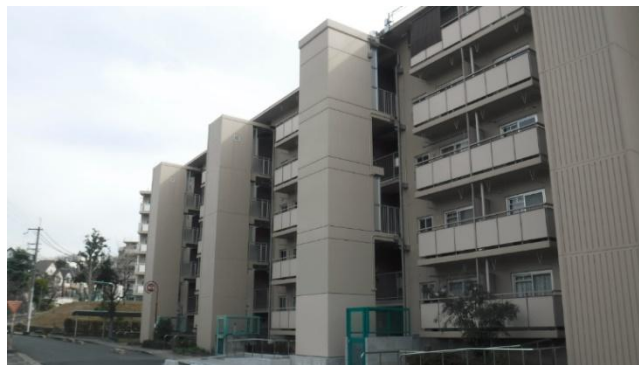
【中層エレベーター設置の事例】
