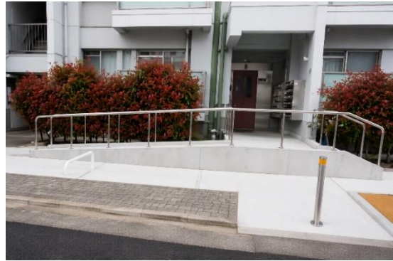
住棟入口へのスロープ改修の例
