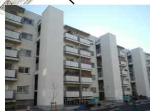
中層エレベーター設置
